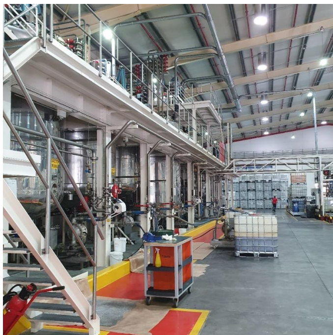
Figura 3.3 – Panorâmica do interior do edifício onde ocorre o processo de fabrico.
