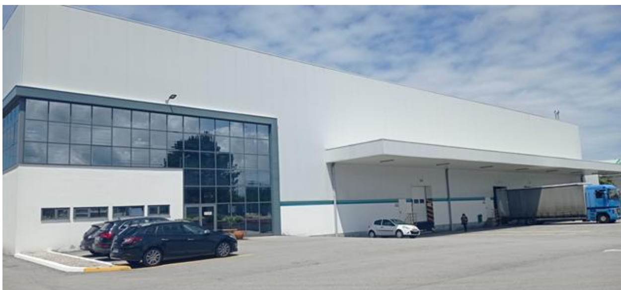
Figura 3.1 - Edifício da FLEXPUR.
