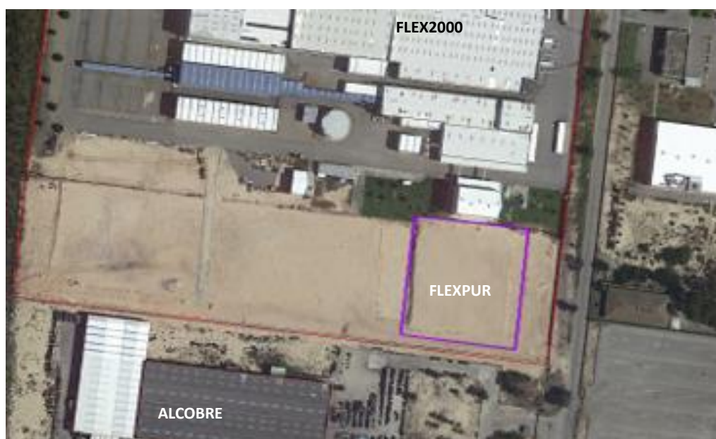
Figura 5.2 – Imagem do Google Earth da área de implantação do projeto (polígono roxo) onde é visível o processo de terraplenagem em todo o perímetro sul do terreno da FLEX2000 – Imagem datada de 11/5/2013).
