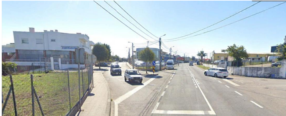
Figura 4.51 –Infraestrutura rodoviária EN109.
