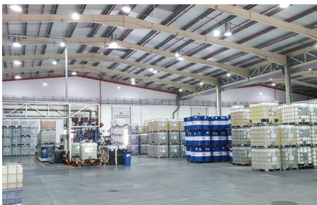
Figura 3.4 – Panorâmica do interior do edifício onde ocorre armazenagem de substâncias.
