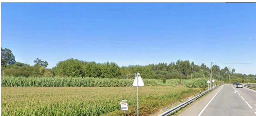
Figura 4.54 – Ribeira de Caster – visualização a partir da infraestrutura rodoviária N109 para Oeste na SUP 6.
